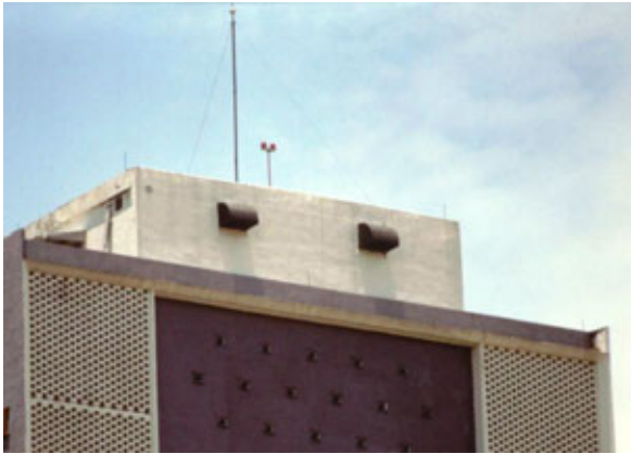
Figura 3: Fotografía del edificio Wisma Tanah tomada en el 2000, que tenía instalado un terminal captador ESE de fabricación francesa.
