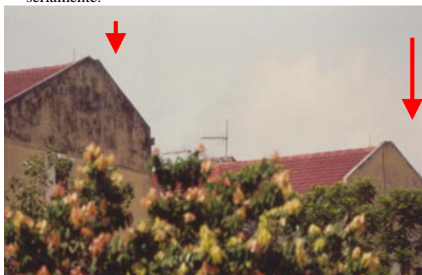
Figura 11: Fotografía de dos bloques de departamentos adyacentes que muestran puntos de impacto similares. En ambos casos, la instalación de las puntas Franklin fue a una distancia de 0,5 m de los extremos de la cubrera.
