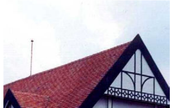
Figura 1: Fotografía del edificio del RSC tomada en 1998. En dicho edificio se instaló un terminal captador ESE de fabricación australiana.
