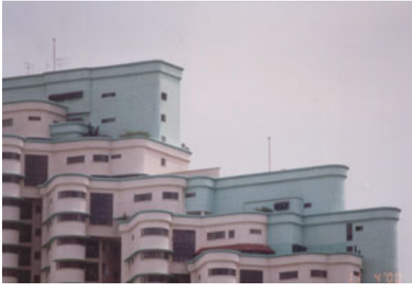
Figura 7: Fotografía de los departamentos Villa Putri que muestran dos captadores ESE de fabricación australiana instalados en los techos de dos niveles.
